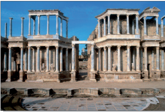
Merida, Bühnenwand des römischen Theaters
